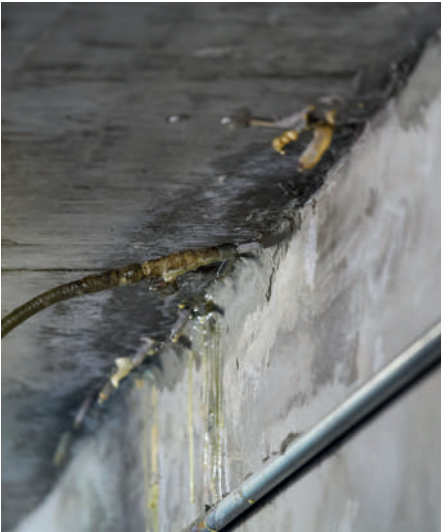
Şekil-3: Tamamlanmış PU Çatlak Enjeksiyonu
